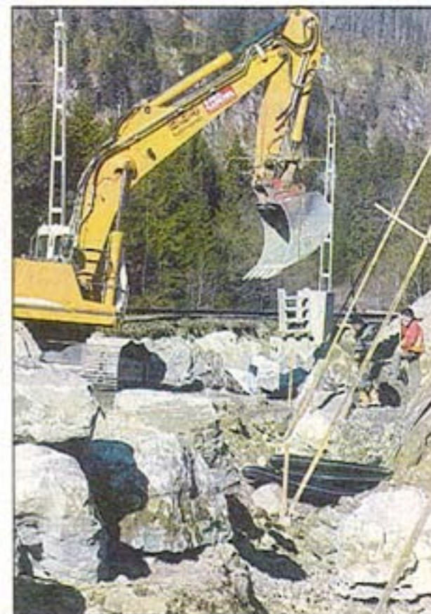
Die Vorarbeiten für den Gleisbau laufen auf Hochtouren. (Fotos: mez)
