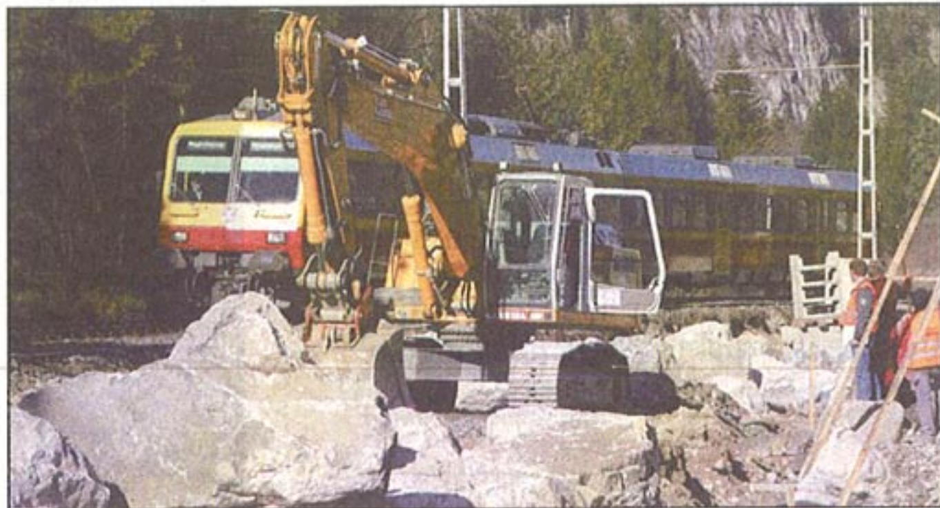
Reger Betrieb herrscht auf der Baustelle der neuen Trasse für die Montafonerbahn. (Foto: meznar-media.com)
