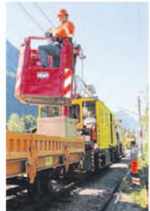
Abschlussarbeiten an der MBS-Strecke in Lorüns.
