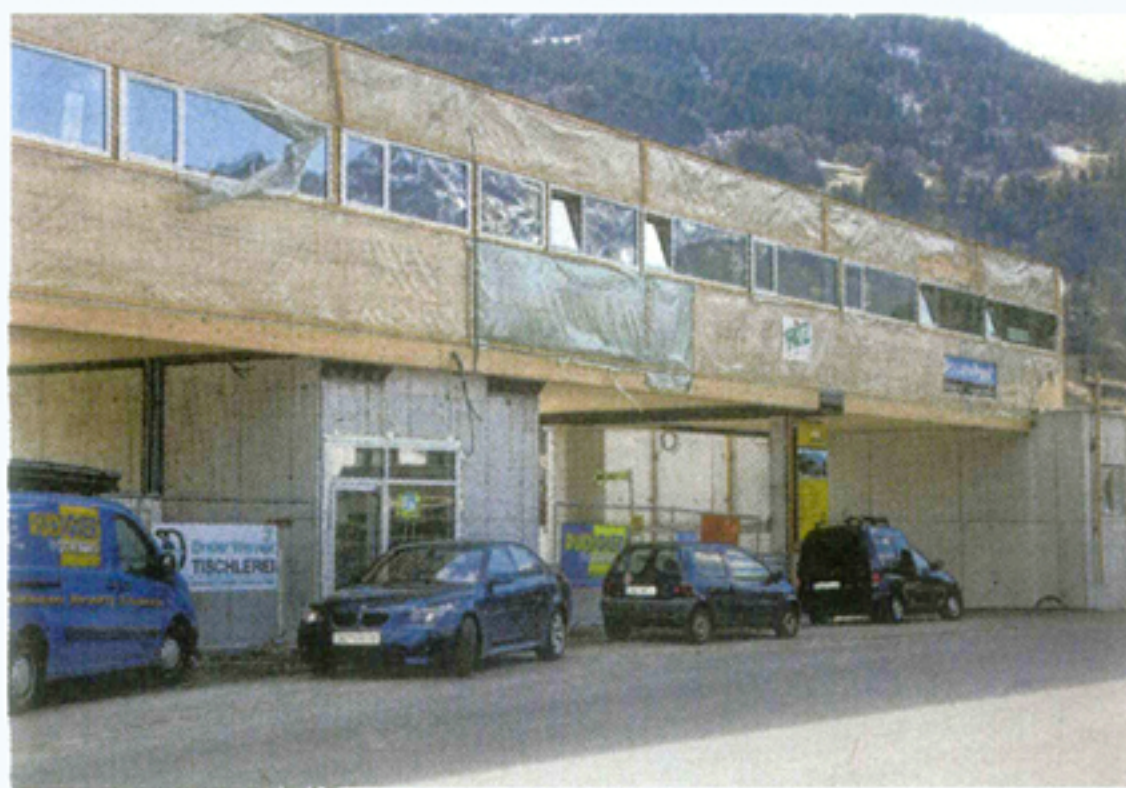
Die Montafonerbahn zieht eine positive Bilanz nach den ersten Monaten in der neuen mbsBus-Zentrale in der Schrunser Batloggstraße.
