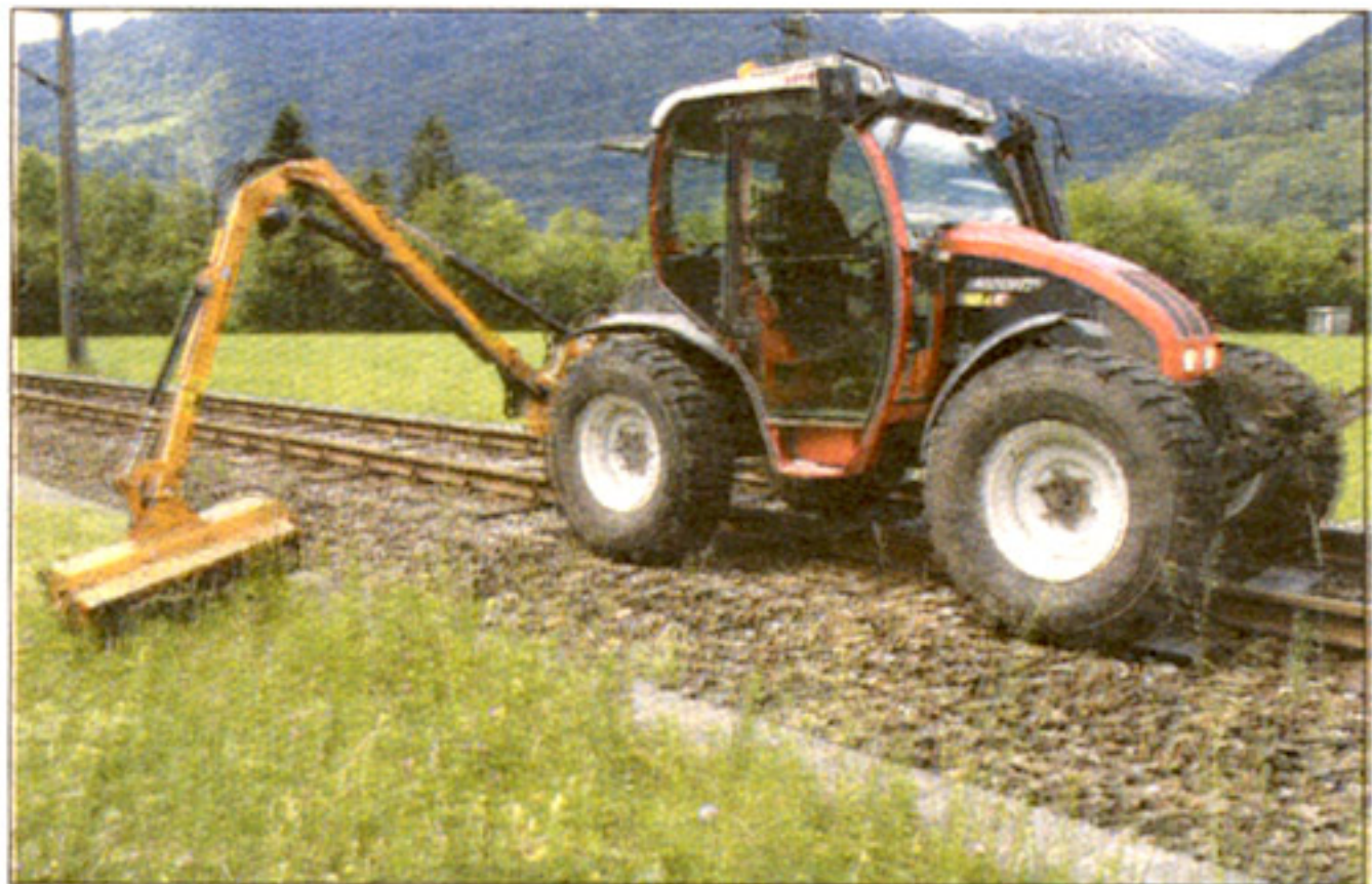
Die Montafonerbahn investiert in die Erhaltung der Bahnstrecke jährlich 190.000 Euro.
