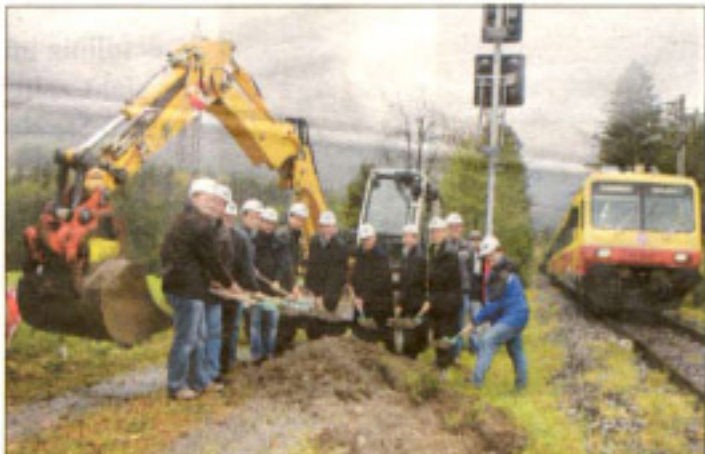
Spatenstich für den Neubau der Montafonerbahn-Trasse in St. Anton im Montafon.
